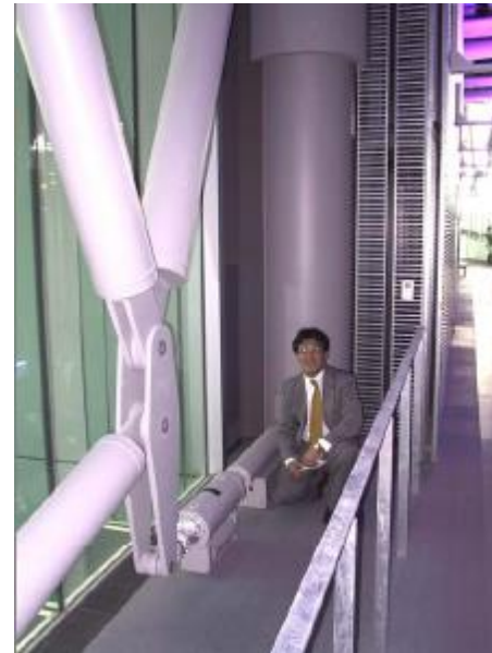
日本Sanwa Tekki公司开发的用于日本东京博物馆的 300kN 磁流变液阻尼器 The 300kN Magnetorheological fluid damper developed by Japanese Sanwa Tekki Company is used in Tokyo Museum
