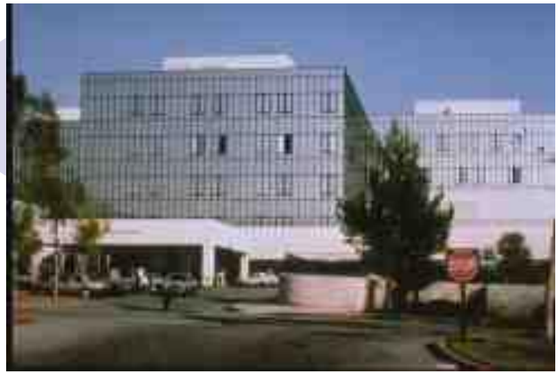
橄榄景医院（抗震结构） The Olive View Hospital (conventional seismic structure)
